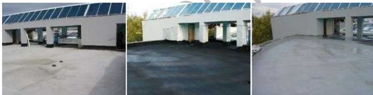
защита покрытия жидкой резиной ACRILET 198 увеличит сроки эксплуатации кровли.
